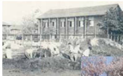
◀校庭整地作業（昭和27年）
